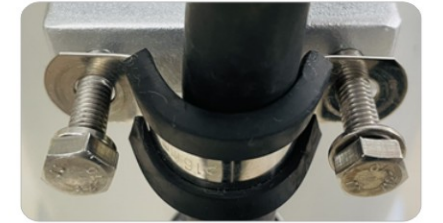
电缆防拖拉结构
